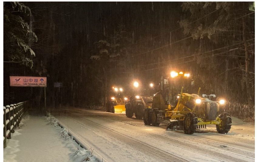
(令和6年2月29日 国道138号 山梨県山中湖村)
