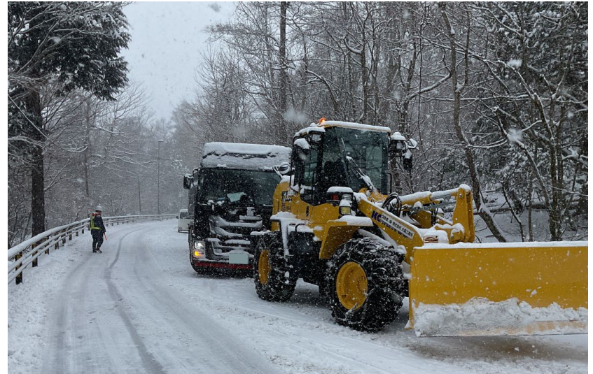
(令和6年2月5日 国道139号 山梨県鳴沢村)
